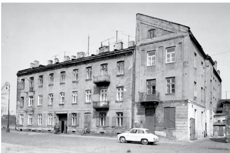
Widok od strony ul. Stolarskiej, 1976 r. [ze zbiorów MWKZ]
