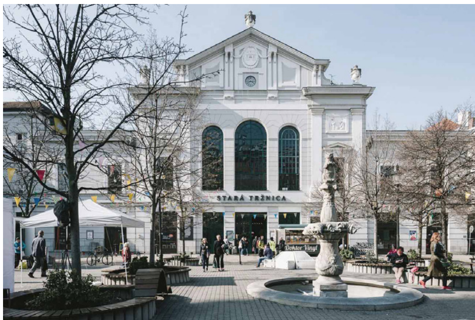
— Stará Tržnica, widok fasady hali targowej z Placu Aksamitnej Rewolucji [fot. Alianca Stará Tržnica]
